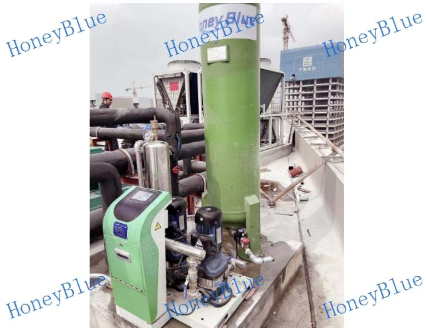
定压补水装置节约用地 普通落地式膨胀水箱的伸缩容积靠胶囊的收缩扩张来实现，罐体的有效容积为罐体总容积的20%~30%，罐体比较庞大，而HGPZJZ型稳压膨胀机组采用特殊技术措施，把膨胀部分和气压稳压部分分开放置，可使系统的绝大部分膨胀量储存于隔离的膨胀器中，设备的体积利用率可达90%以上，因此整机体积、高度大为缩小，节约用地50%~60%。便于设备布置、安装，又节约了机房的土建成本。安全可靠 采用先进的自控系统，具有双泵交替运行和事故漏水双泵同时运行功能，具有低水位保护、防压力不稳等功能，可确保装置安全稳定运行。使用寿命长 采用不锈钢多级泵和特殊设计的进口稳压装置，可提高机组寿命，同时符合不同条件下的运行工况。安装方便 传统的定压补水机组一般散件运输，现场安装，施工难度加大，设备的可靠性差。而稳压膨胀机组整机出厂，现场需接好进出水口和电源就可，简单快捷。远程控制 机组控制柜可与楼宇自控系统连接，远程控制补水泵的启停，并通过每台补水泵出口设置的水流开关，检测补水泵的运行状态。补水装置，就选喜蓝（上海）环境科技有限公司，让您满意，欢迎您的来电哦！福建自动补水装置用途
